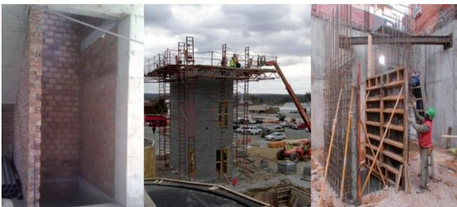
Fig. 1: Soluciones arquitectónicas utilizadas habitualmente en huecos de ascensor
