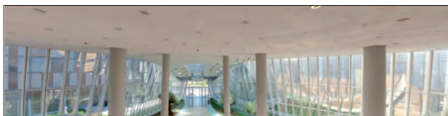
Atrio de entrada. Imagen propiedad de Torre Iberdrola AIE
