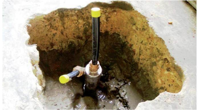
Fig. 4: Cabezal micropilote termoactivo (Fuente: elaboración propia)
