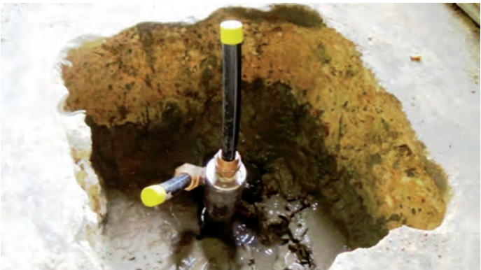
Fig. 4: Cabezal micropilote termoactivo (Fuente: elaboración propia)
