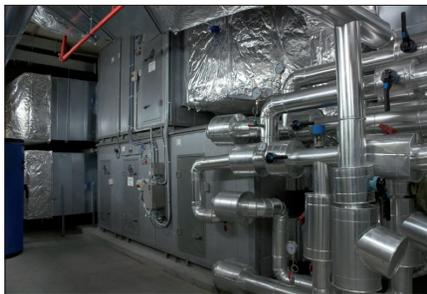
Imagen de una Unidad de Tratamiento de Aire de Ventilación. Imagen propiedad de Torre Iberdrola AIE
