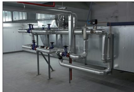
Dosificación de vapor en el aire de ventilación. Imagen propiedad de Torre Iberdrola AIE
