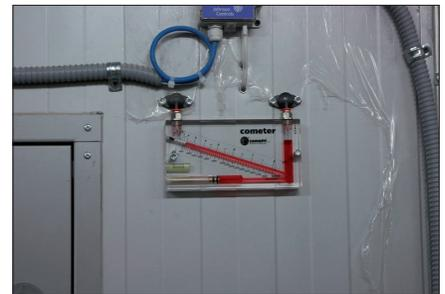
Medida de presión de aire para control de ventiladores. Imagen propiedad de Torre Iberdrola AIE
