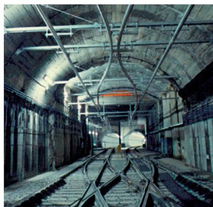
Fig. 4: Catenaria rígida instalada en un túnel
