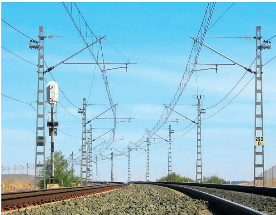
Fig. 3: Vía doble con catenaria convencional
