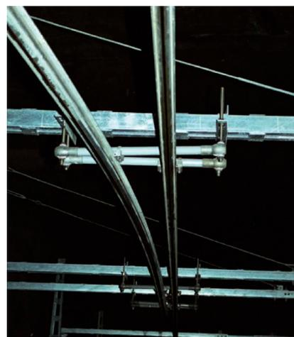
Fig. 9: Aguja aérea realizada con catenaria rígida
