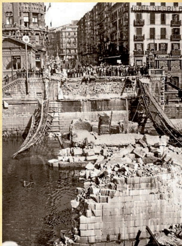
Estado del llamado Puente de Isabel II o del Arenal en junio de 1937. En el edificio de la parte superior izquierda, propiedad de la Sociedad Bilbaína, se ubicaba la Asociación de Ingenieros Industriales de Bilbao y la Revista DYNA
