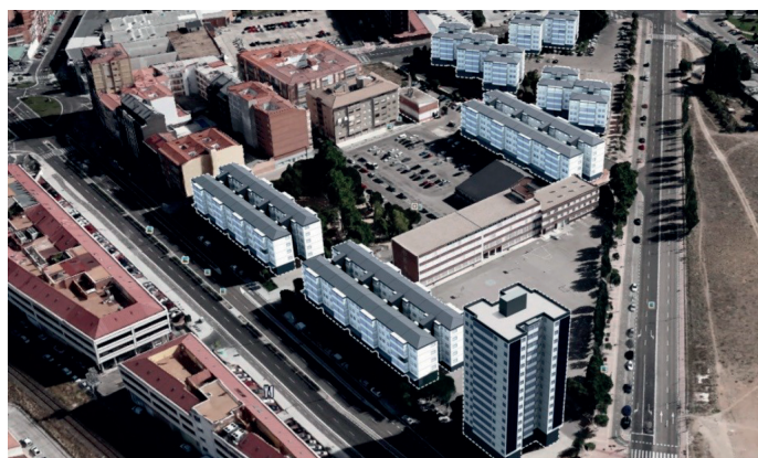
Fig. 1: Vista aérea de la rehabilitación del distrito FASA
