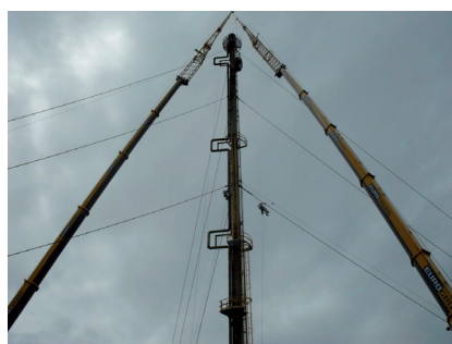
Fig. 2: Trabajos en antorcha empleando grúas y canastillas, en combinación con técnicas verticales para inspección y engrase de vientos
