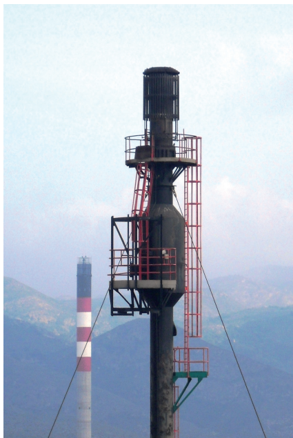
Fig. 9: Detalle de la zona de quemadores (tip) de una antorcha
