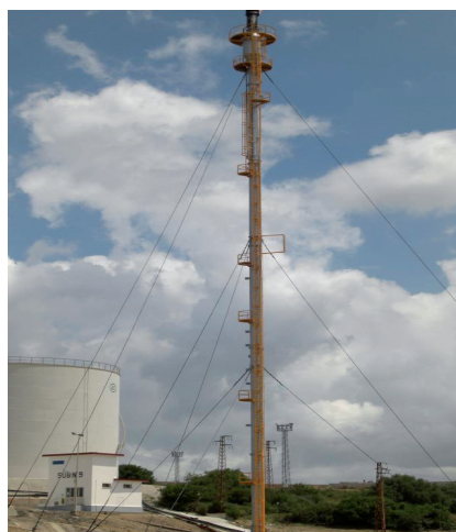
Fig. 1: Vista general de una antorcha típica fijada con vientos
