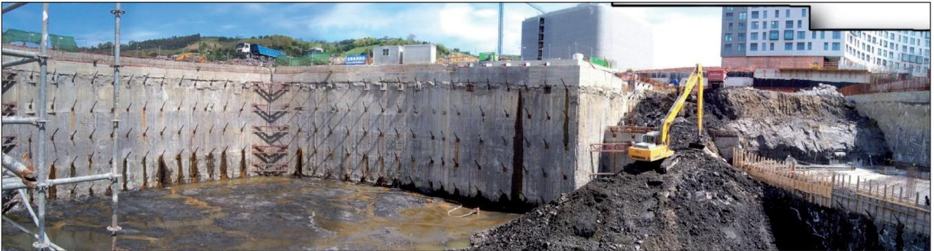
Figura 6. Muros pantalla. excavación hasta el nivel de apoyo de la cimentación de la torre. Imagen propiedad de Torre Iberdrola AIE.
