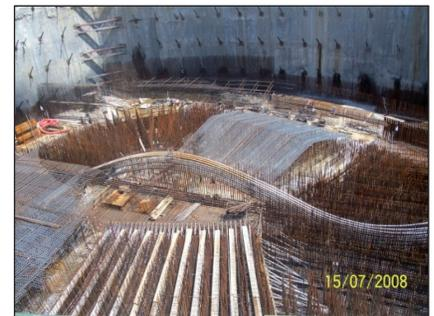
Figura 7: Cimentación de la torre. Imagen propiedad de Torre Iberdrola AIE
