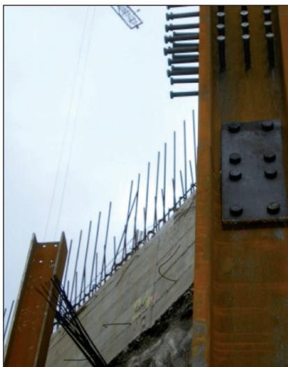
Figura 11: Pilares mixtos. Conexión a axil entre tramos consecutivos. Imagen propiedad de Torre Iberdrola AIE
