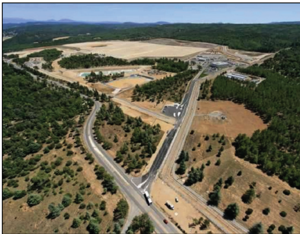
Estado reciente de la preparación de los terrenos para iniciar la obra con los edificios del Proyecto ITER. La plataforma de la instalación para la fusión mide 400 x 1.000 m. ( www.iter.org )
