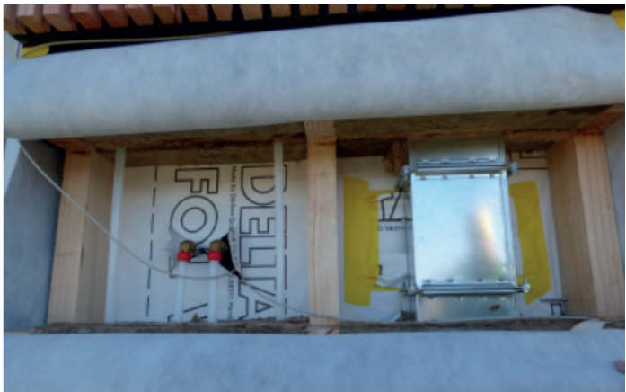
Fig. 2: Módulo de instalaciones BERTIM. Las piezas en forma de T acoplan tuberías y conductos de dos módulos y penetran en las viviendas. [Fuente: proyecto BERTIM]
