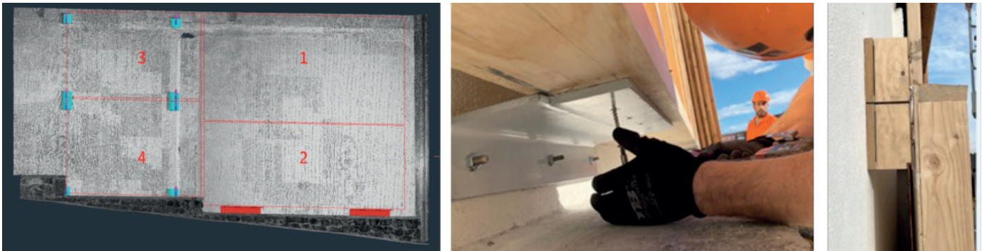
Fig. 3: Izda: Identificación de las zonas para la distribución de módulos en el muro; Centro: Estrategia 1: sistema tradicional de instalación; Dcha: Estrategia 2: instalación con el sistema Matching Kit [Fuente: proyecto BERTIM]
