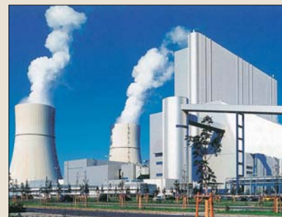
Central térmica sin emisión de CO 2
