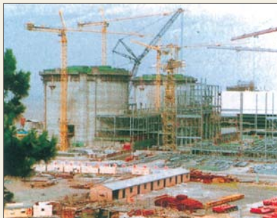
Construcción de la Fase III de la central nuclear Quishan, en China.
