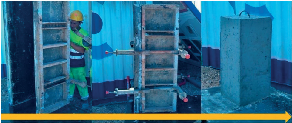
Fig. 1: Fabricación de la columna mediante métodos convencionales
