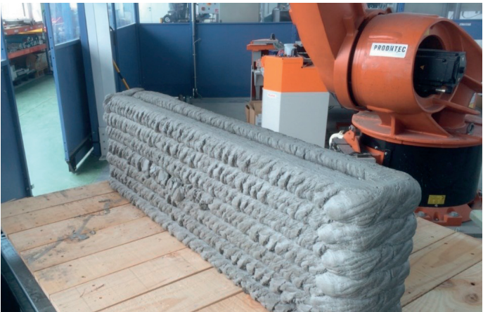
Fig. 4: Impresión 3D en hormigón de la viga
