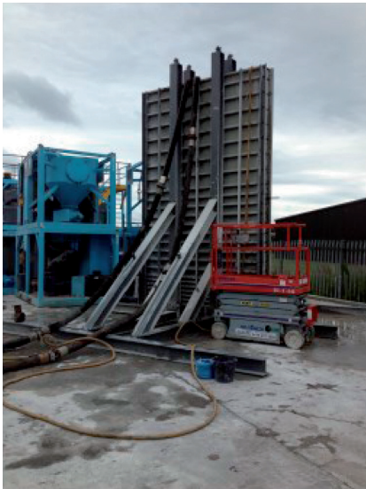
Fig. 4: Estructura de encofrado
